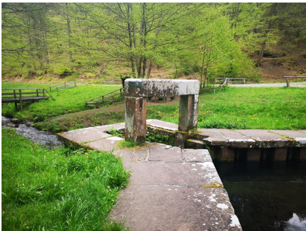
Auslaufbauwerk mit Damm des Biedenbacher Woogs (Anja Jung , 2019)
