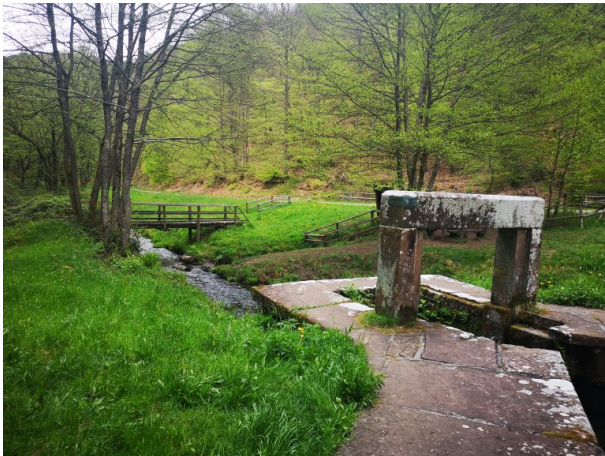
Absperrbauwerk beim Biedenbacher Woog (Anja Jung , 2019)
