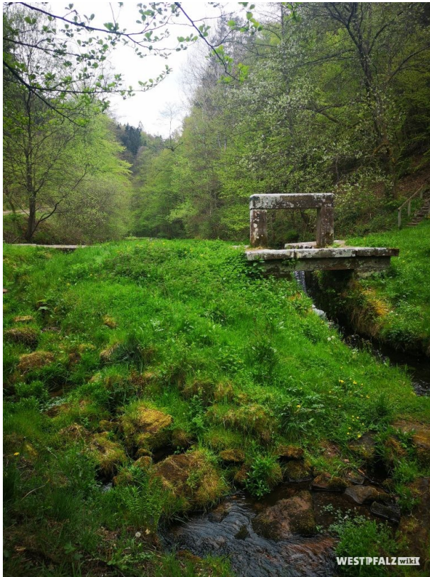
Absperrbauwerk mit Sandsteinstaudamm am Leinbach (Anja Jung , 2019)
