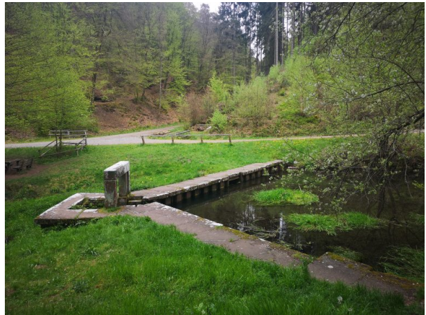
Biedenbacher Woog mit Absperrbauwerk und Woogeingassung mit Dammkörper (Anja Jung , 2019)
