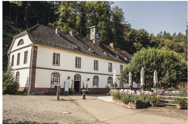
Ehemaliges Wirtschaftshaus am Unterhammer. Heute ist dort ein Café untergebracht (Benjamin Hörle, 2016)
